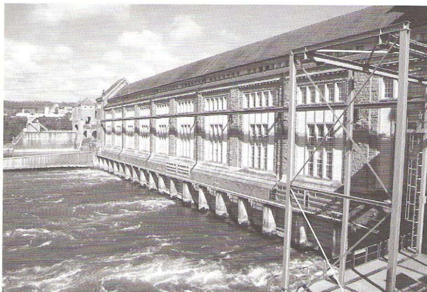
Bild 1: Unterwasser des Laufwasserkraftwerks Laufenburg (Quelle: Hildebrandt)
